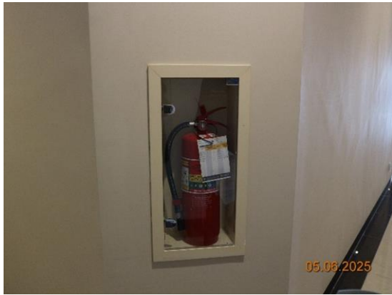
รูปที่ 2.4-9 ถังดับเพลิงเคมีแบบมือถือ
