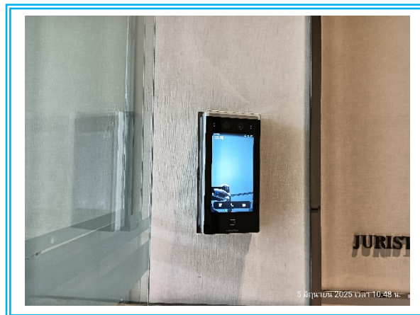
รูปที่ 3-58 ระบบสแกนหน้าบริเวณทางเข้า-ออก โถงต้อนรับของอาคาร
