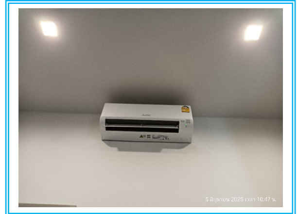
รูปที่ 3-32 เครื่องปรับอากาศแบบประหยัดพลังงาน
